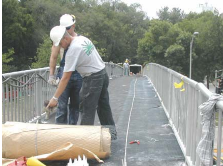
Kuva 9. Titaaniverkon asentamista siltakannelle /27/.
