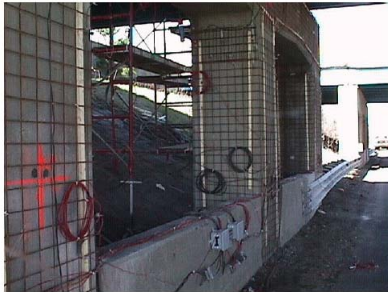
Kuva 7. Anodiverkon asennus /34/.
