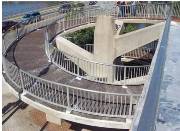
Kuva 10. Rampeille asennetut teräsverkkoanodit /27/.
