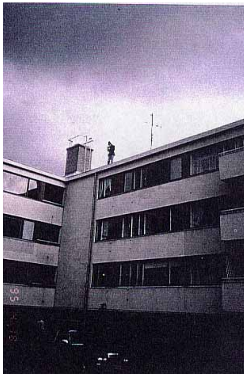
Kuva 6. Signaalimerkkien kiinnittämistä räystäälle.
