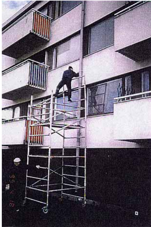
Kuva 5. Signaalimerkkien kiinnittämistä seinän keskikorkeudelle.
