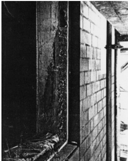
Kuva 12. Saksalainen eriytetty julkisivurakenne heti ulkolevyn asennuksen jälkeen. Tässä kohteessa ei julkisivussa ole tuuletusrakoa eikä avosaumojia.
