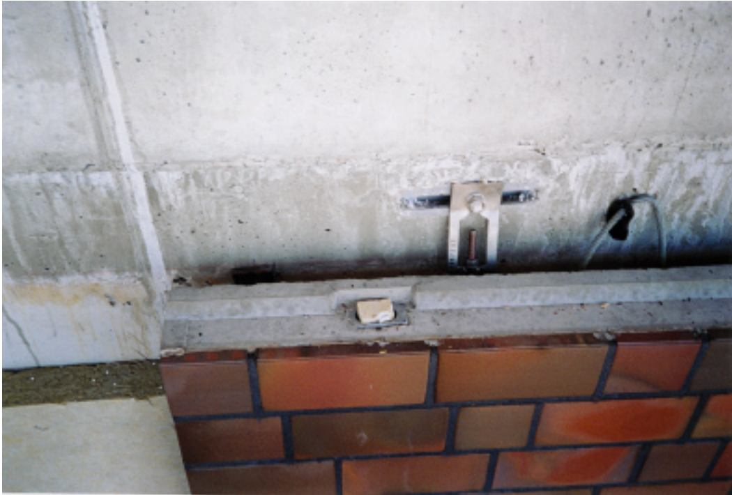
Kuva 11. Saksalaisen eriytetyn betonijulkisivun ulkolevyn yläpään kiinnitys heti asennuksen jälkeen.
