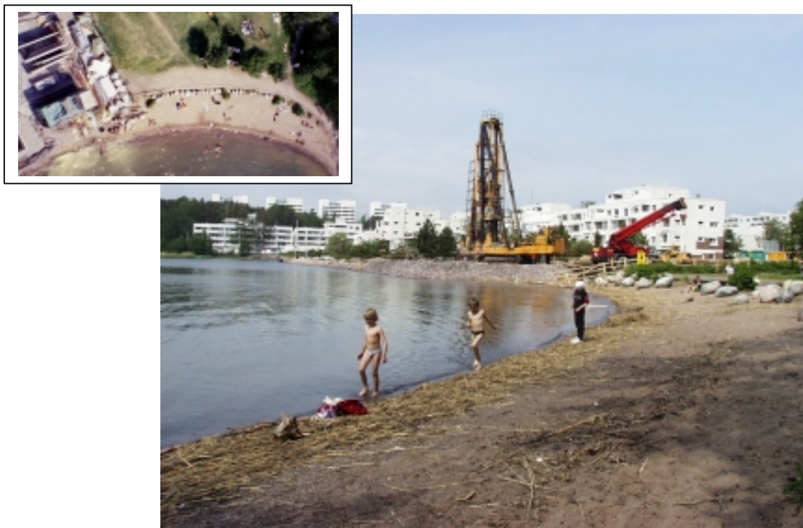
Kuva 2.3. Kaivinpaalutustyöt käynnissä asutuksen keskellä yleisen uimarannan vieressä. (kesäkuu 1998). Pikkukuvassa sama ranta rakennuksen ylimmästä kerroksesta kuvattuna vuotta myöhemmin (kesäkuu 1999).
