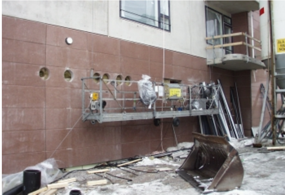
Kuva 5.20. Elementtisaumausurakoitsijan riipputeline (maaliskuu 1999).
