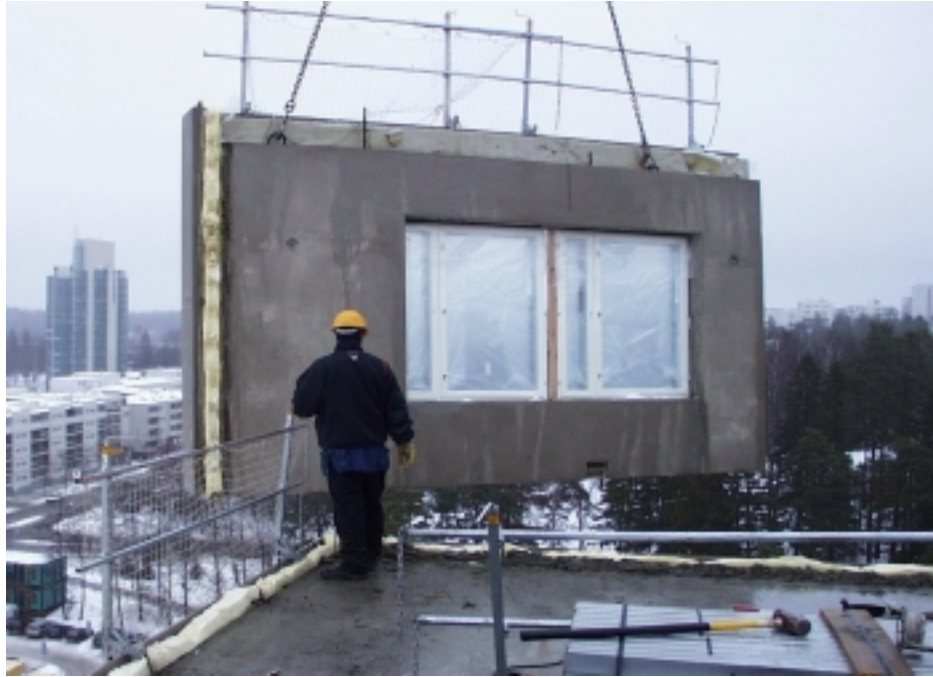
Kuva 5.12. Seinäelementin asennusta. Nurkassa näkyvä villakaista ja kaiteet on kiinnitetty alhaalla ennen elementin nostoa (joulukuu 1998).
