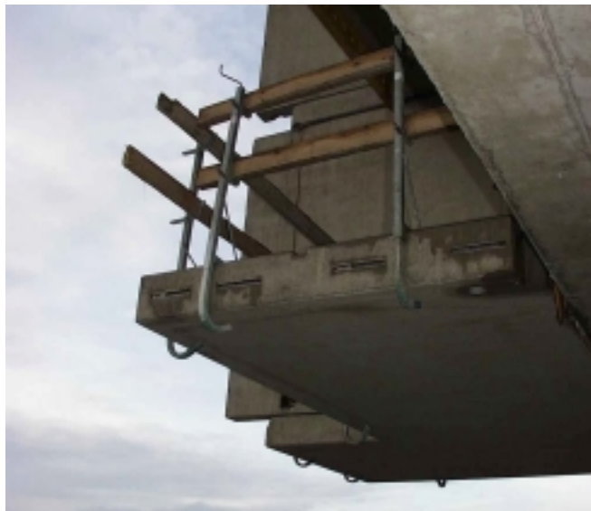
Kuva 5.7. Myös parvekelaattojen kaiteet kiinnitettiin valmiiksi maassa.
