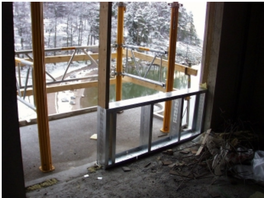
Kuva 5.10. Parveketaustat rakennettiin paikalla teräsrankarunkoisina. Tukitornin siirtäminen oli eräs putoamisen kannalta riskialtteimmista työvaiheista.
