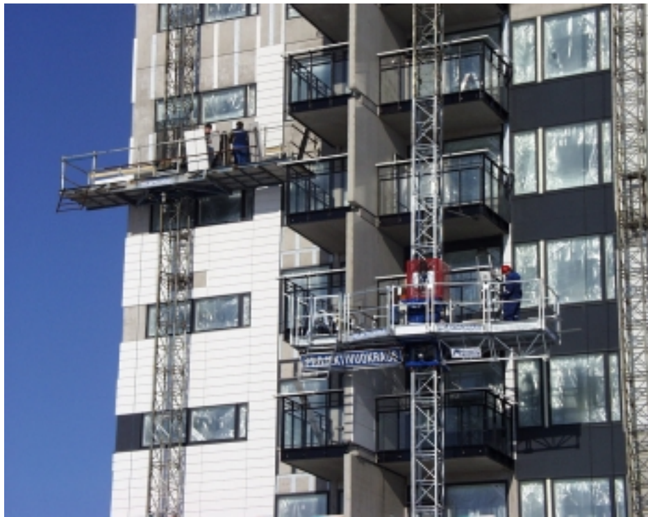
Kuva 5.21. Julkisivupellitys aloitettiin meren puolelta maaliskuussa 1999. Kaikki kolme mastolavaa pystytettiin aluksi samalla julkisivulle.
