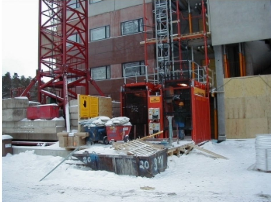
Kuva 5.5. Kerroksiin vietävien materiaalien purkupaikkana toimi rakennushissien eteen rakennettu taso (helmikuu 1999).
