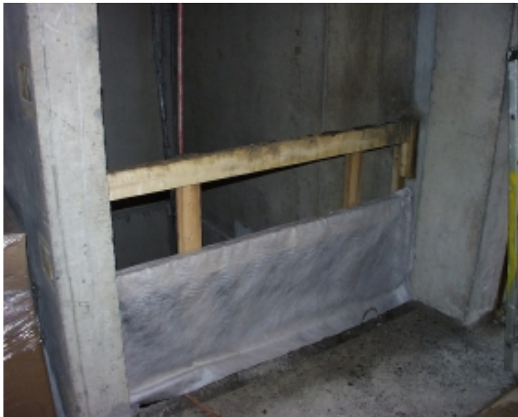
Kuva 5.9. Hissikuilun kaideratkaisu kehitettiin erityisesti Meritornin työmaalle. Kaiteeseen kiinnitetty suodatinkangas estää kappaleiden putoamisen käytävältä hissikuiluun. Kaide on helposti irrotettavissa.
