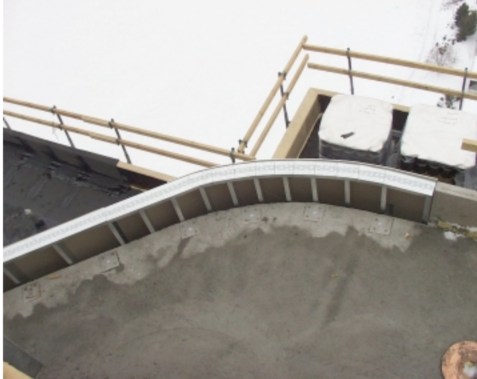
Kuva 5.16. Kuva otettu rakennuksen katolta alaspäin. Kuvanottohetkellä vesieristystyöt ovat alkaneet. Kuvassa keskellä näkyy 20. kerroksessa oleva teräsrankarunkoinen kaareva seinä
