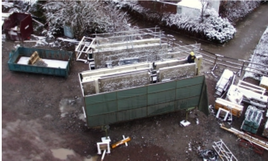
Kuva 5.6. Suojaverkoilla varustetut villavälikaiteet kiinnitettiin elementteihin jo alhaalla (marraskuu 1998).
