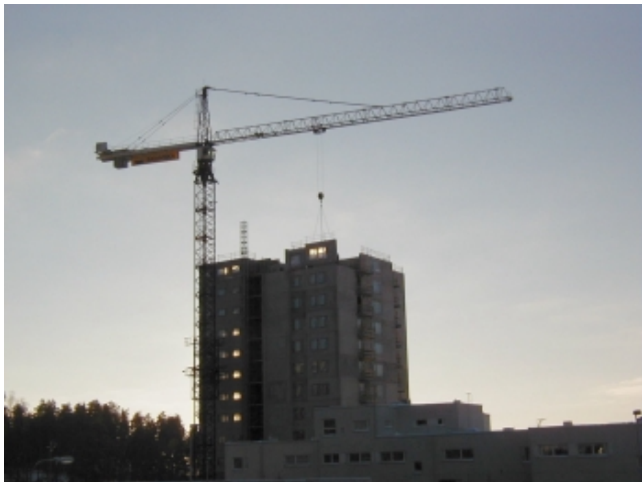
Kuva 4.1. Meritorin työmaa vastaavan mestarin tuoilta nähtynä joulukuussa 1998.
