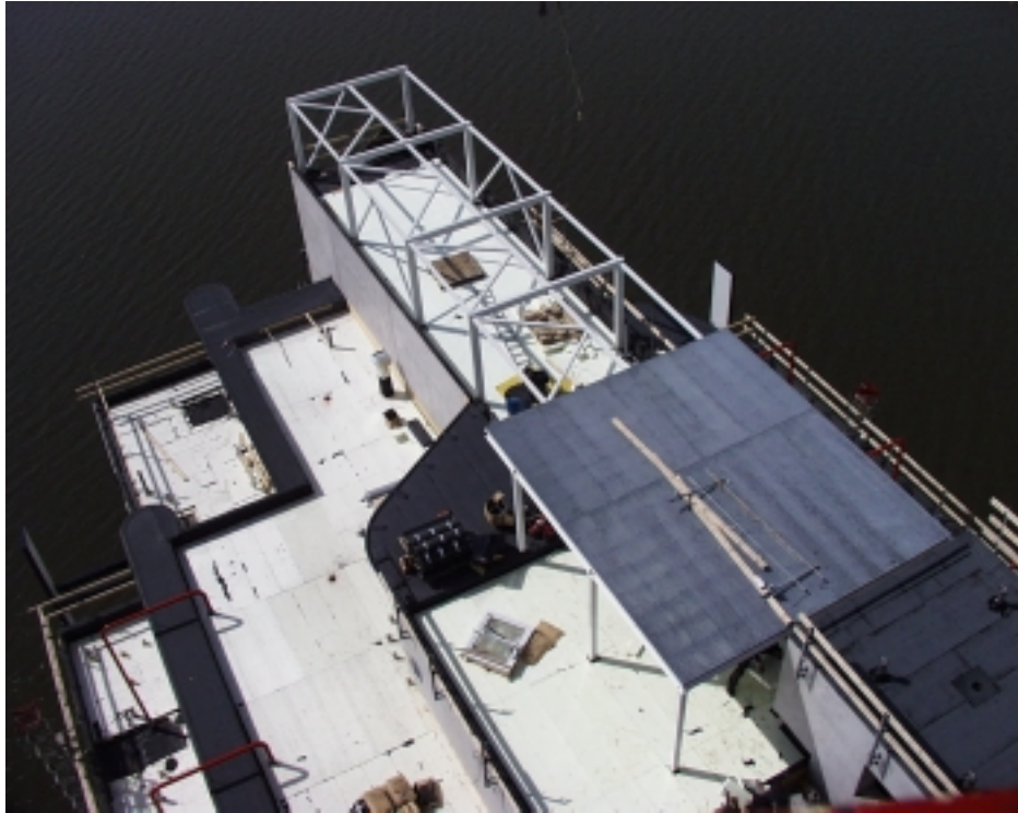
Kuva 5.17. Meritorin ullakon teräsrakenteita, etualalla helikopteritasanne (toukokuu 1999).
