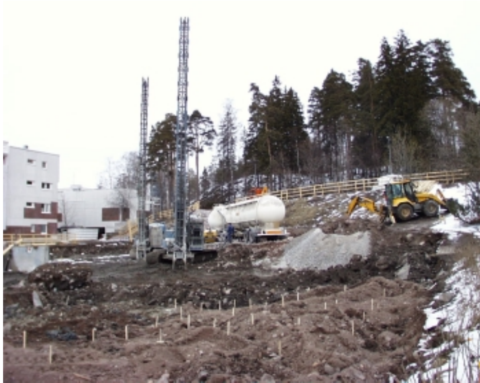
Kuva 3.3. Riskien arviointipalaverin järjestämisen aikaan työmaalla oli käynnissä kalkkistabilointi (huhti–toukokuu 1998).
