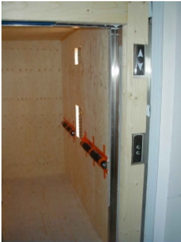
Kuva 5.28. Hissi vanerilla kauttaaltaan suojattuna. Työmaalla oli kehitetty materiaalsiirtokäyttöä varten kynnysratkaisu, joka esti oven sulkeutumisen kesken lastauksen.
