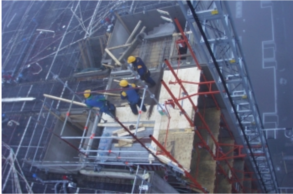
Kuva 5.27. Rakennushissiä korotettiin viikoittain rungon noustessa (tammikuu 1999).
