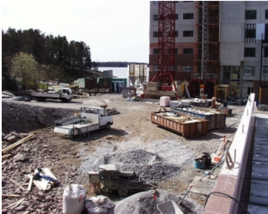
Kuva 5.11. Jätelavoja siirrettiin työmaan torninosturilla tarpeen mukaan.
