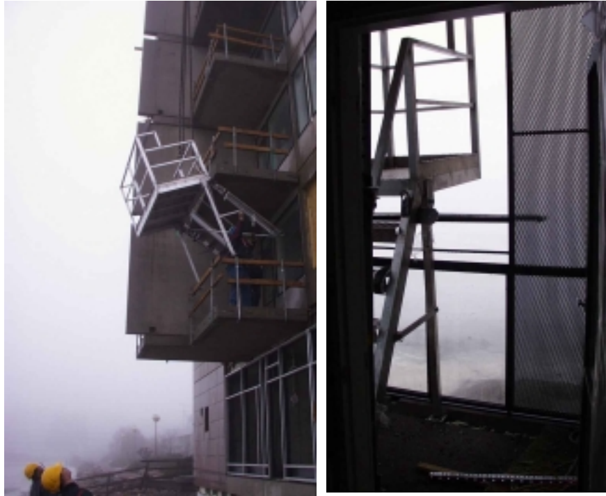
Kuva 5.24. Parvekekaideasennusta varten tehdyn alumiinirunkoisen asennustelineen testausta (tammikuu 1999).
