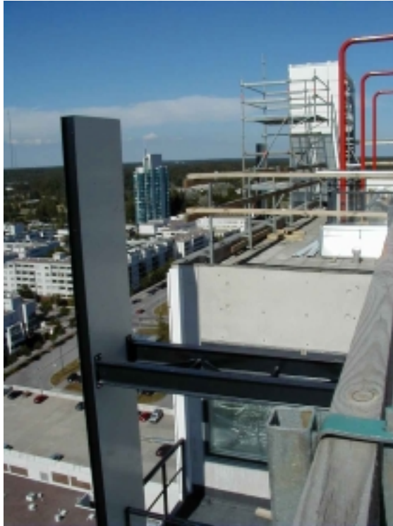
Kuva 5.19. Parvekelinjojen jatkeina toimivien siivekkeiden asennus onnistui odotettua helpommin.
