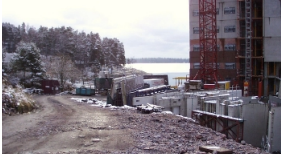
Kuva 5.4. Työmaatie alas tontille pengerrettiin viistosti tontin poikki sen jyrkkyyden takia. Elementit varastoitiin kontissa tai elementtifakissa. (marraskuu 1998).
