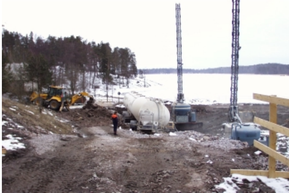
Kuva 3.4. Kuva on otettu Aallokko-tieltä työmaatien yläpäästä. Kuvasta voi arvioida tontin haasteellisuutta. Kuva on otettu samana päivänä kuin kuva 3.3.
