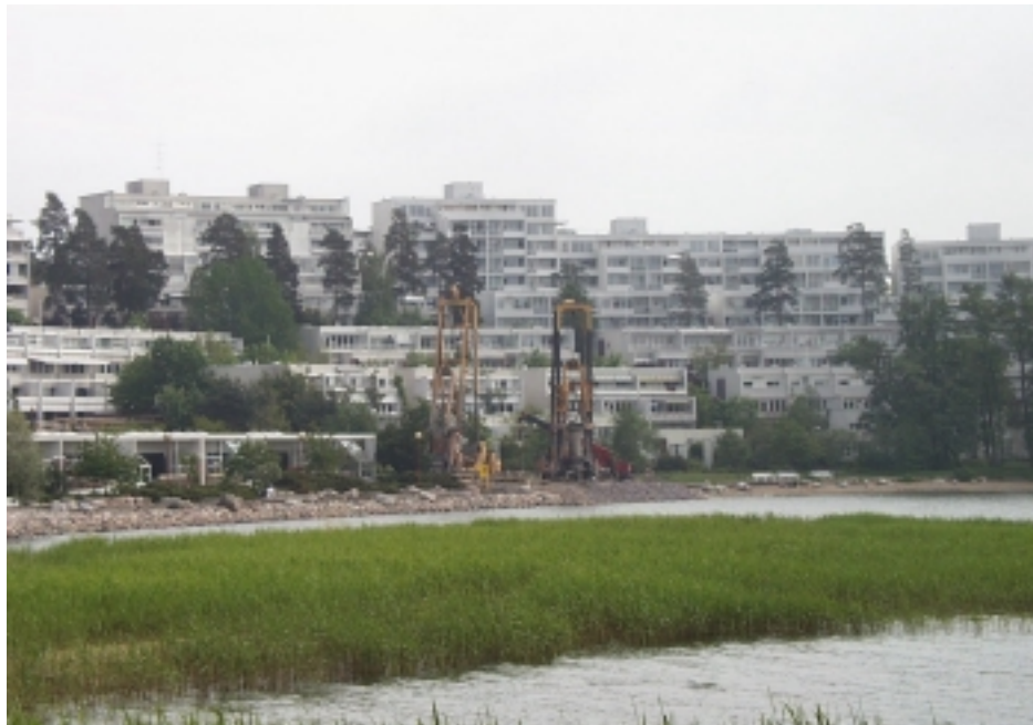
Kuva 2.1. Meritorin rakennuspaikka rajautui merenrannan ja Aallokko-tien väliin sekä pohjoisessa rivi- ja pienkerrostalo-yhtiön raja- ja tontin eteläpuolella kuvassa oikealla näkyvään uimarantaan (kesäkuu 1998).
