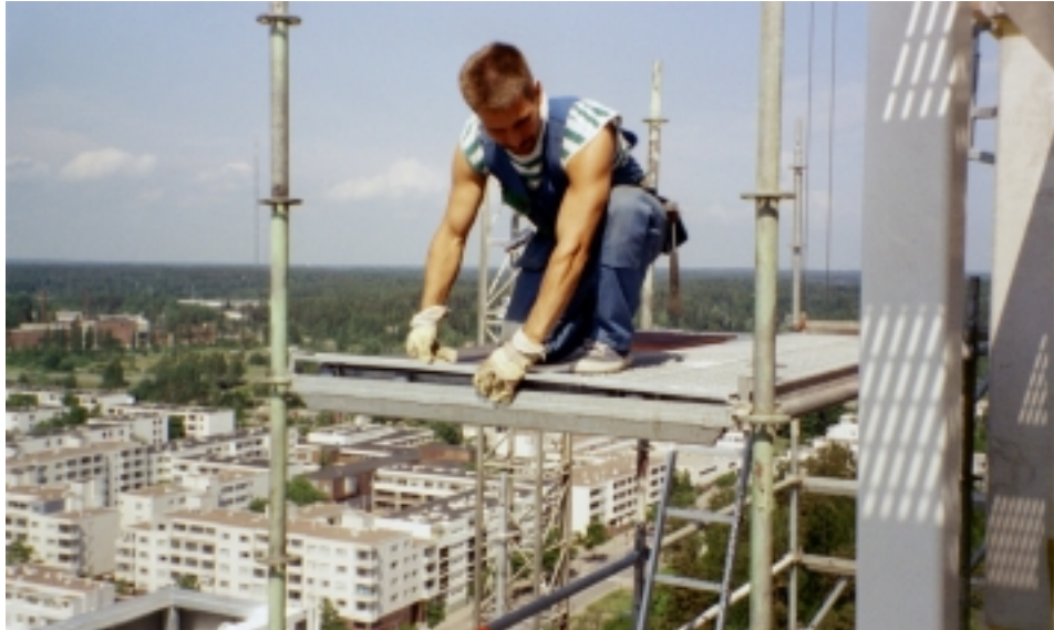
Kuva 5.26. Telineasennusta (kesäkuu 1999).
