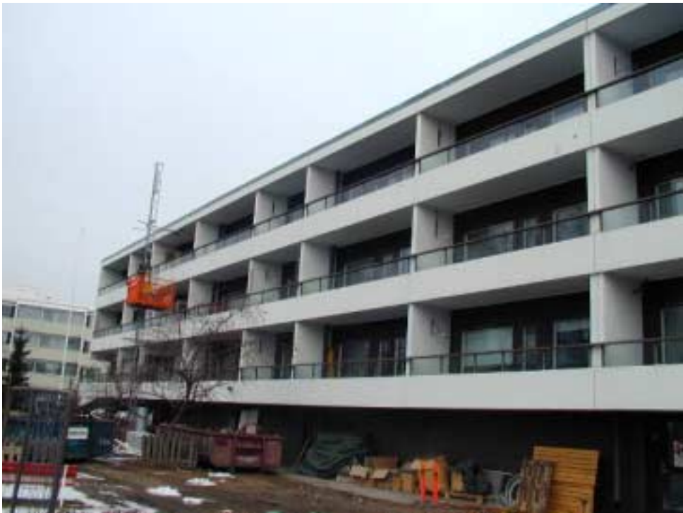
Kuva 10. NCC:n korjausrakennustyömaa Helsingissä.
