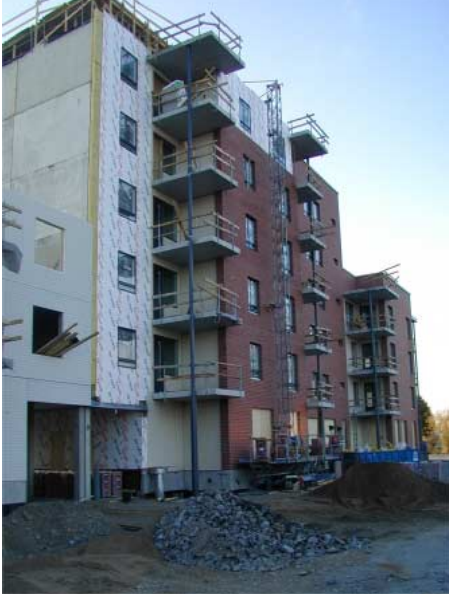
Kuva 4. YIT:n työmaa Tampereelta.
