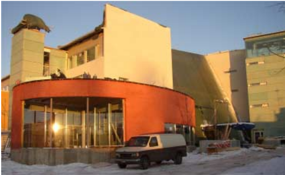
Kuva 7. Hartelan työmaa Korsokeskus.
